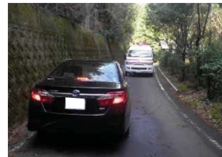
すれ違いが困難な現道区間
