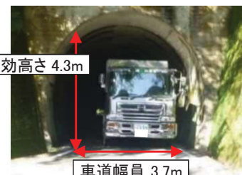
③狭小トンネル（小森トンネル）
