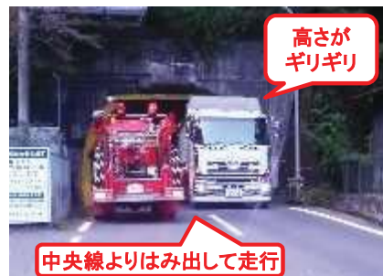
〔南側坑口(上北山村)〕 大型車すれ違い困難状況
