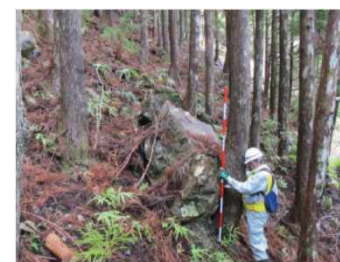
①垂直法面の上にある浮石
