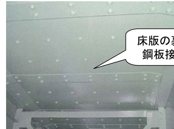
床版補修例 (主要地方道 橋本五条線 両国橋)
