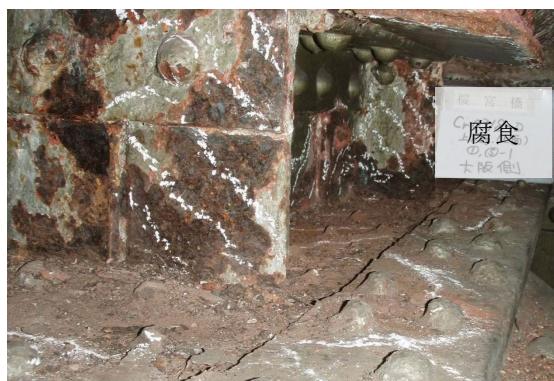
国道 1 号 桜宮橋（単純鋼リベットアーチ橋 1930 年完成 供用年数 95 年）
