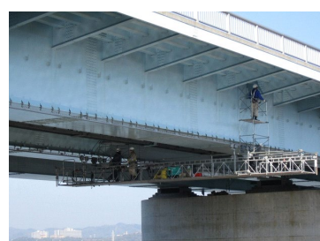
移動式吊足場による点検
