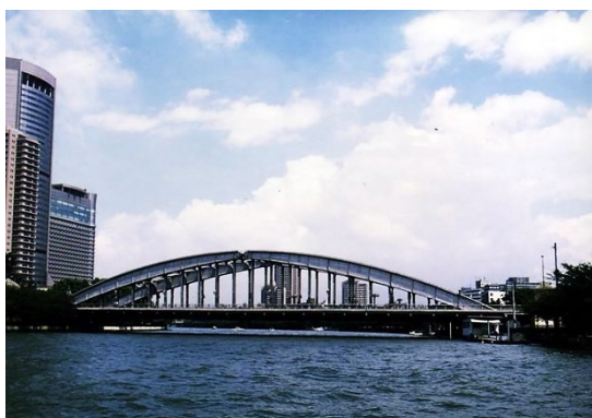
国道 1 号 桜宮橋（単純鋼リベットアーチ橋 1930 年完成 供用年数 95 年）
