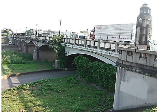
国道 1 号 鳥羽大橋（6 径間連続RCアーチ橋 1934 年完成 供用年数 91 年）
