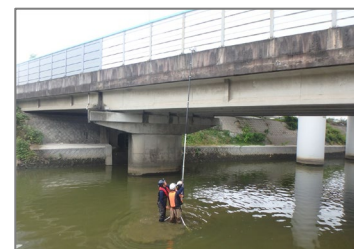
移動式吊足場による点検
