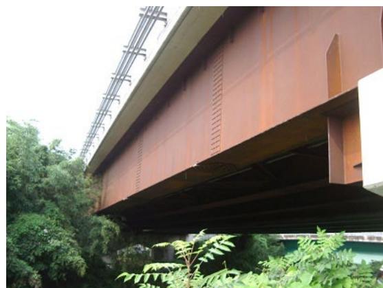
国道175号 天神橋(単純鋼非合成版桁橋)
