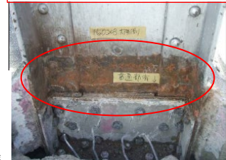
腐食(吊り材…床版下面側)
