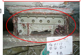
腐食(吊り材…床版下面側)
