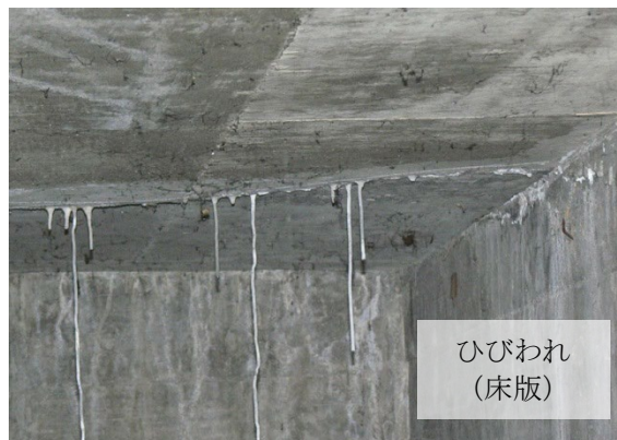
国道 1 号 鳥羽大橋（6 径間連続RCアーチ橋 1934 年完成 供用年数 91 年）
