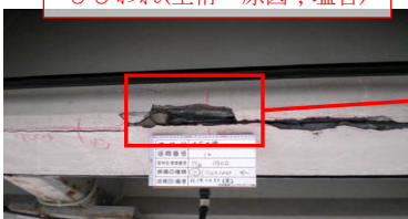
ひびわれ(主桁 原因；塩害)
