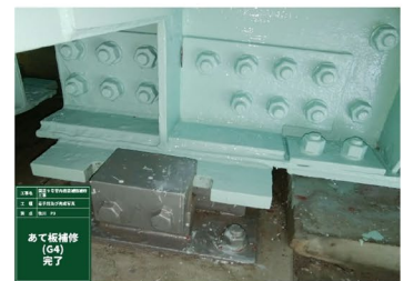
あて板補強と支承の交換
