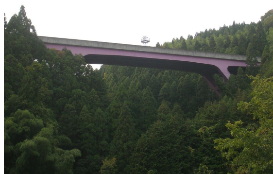
国道27号 塩出橋(3径間連続鋼溶接方杖ラーメン橋)
