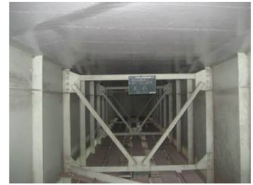
床版下面に炭素繊維シートを接着
