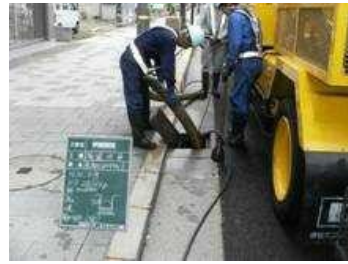
排水構造物清掃
