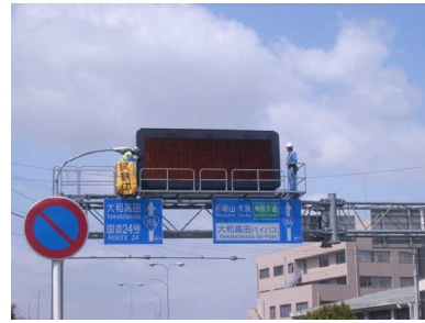
道路情報板の点検
