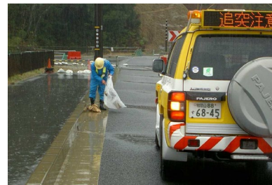
道路巡回（落下物の処理）
