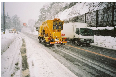
凍結防止材の散布作業
