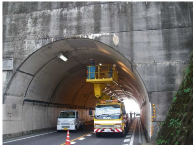
トンネル施設点検状況
