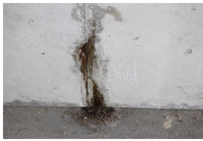
目地のズレ・湧水・土砂流出
