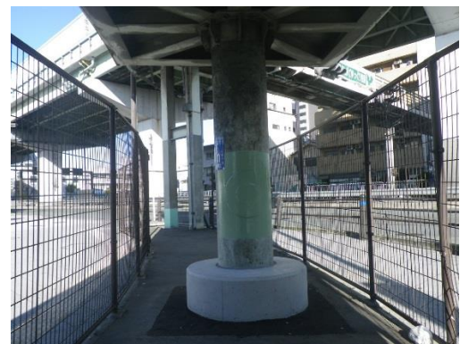
国道43号 大正2号横断歩道橋 内部コンクリート充填+巻きコンクリート
