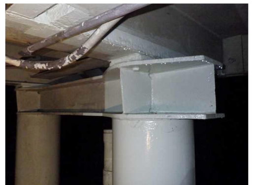
防錆処理・補修塗装
