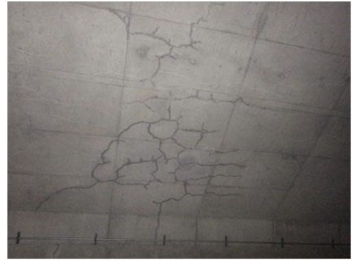
ひび割れの注入材による補修
