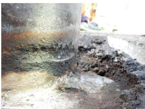
支柱の腐食
