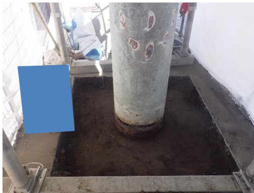
国道43号 大正2号横断歩道橋 内部コンクリート充填+巻きコンクリート
