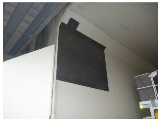
補修状況（剥落対策）
