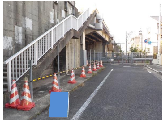
国道2号 茶屋跨線側歩道橋 塗装塗り替え
