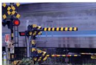
大型遮断機 +二段型遮断装置
