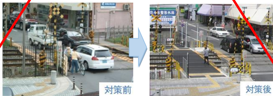
写真 2-1-26 踏切拡幅（歩道新設）の例
