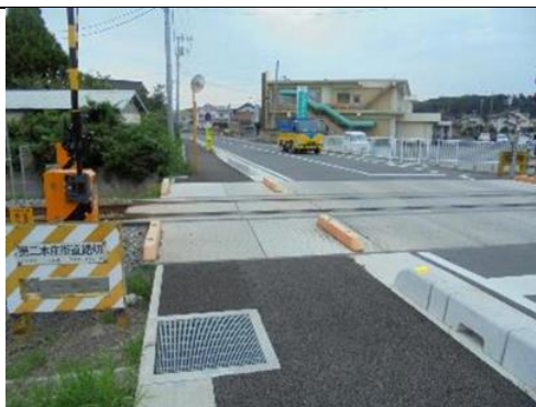
写真 2-1-27 縁石等により分離している例
