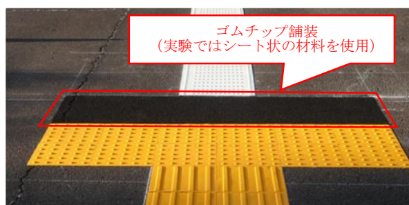
写真 2-7-27 評価実験で実施したゴムチップ舗装
