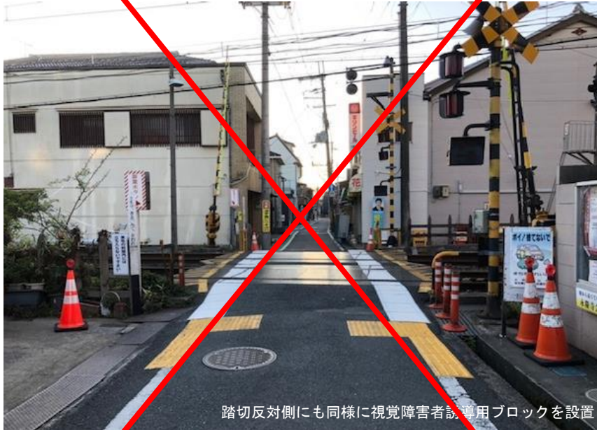
写真 2-7-8 踏切道手前部に視覚障害者誘導用ブロックを設置した事例
