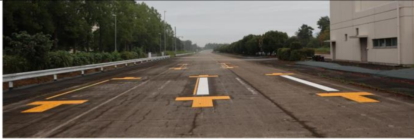
写真 2-7-18 予備実験（踏切内）の誘導表示等の敷設状況
