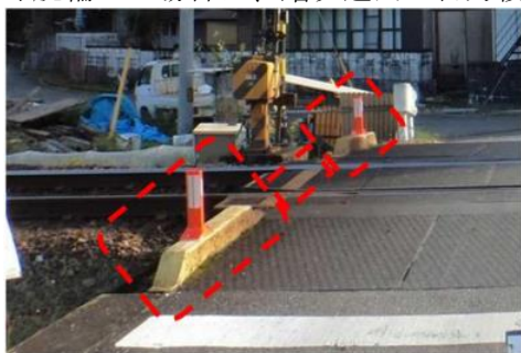
写真 2-7-32 踏切道端部のブロック、ラバーポール及び路面標示の設置事例
