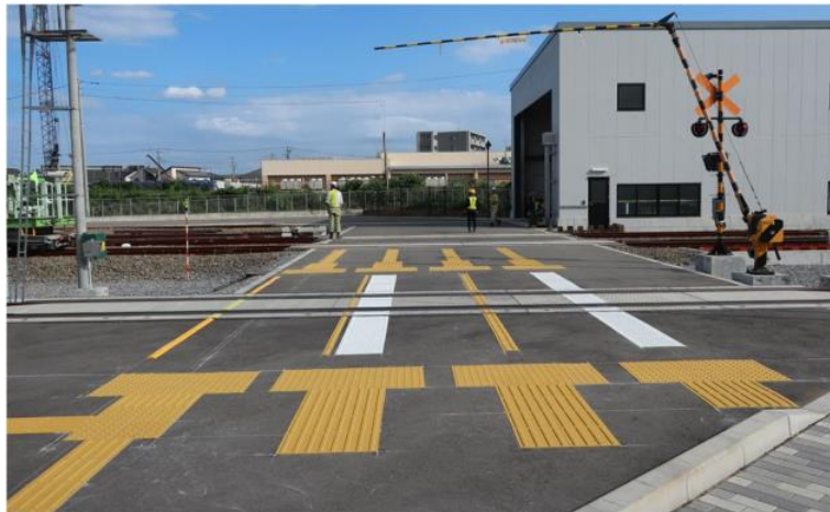
写真 2-7-19 本実験の誘導表示等の敷設状況
