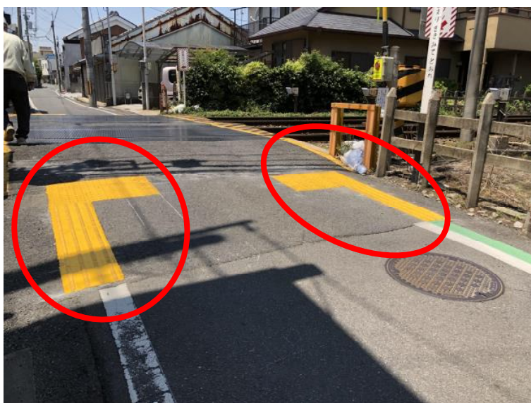
写真 2-7-16 視覚障害者誘導用ブロックを車道上に設置した事例 （令和6年1月の本ガイドライン改定前に設置した事例）
