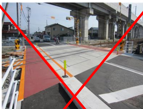
写真 2-1-28 カラー舗装の例
