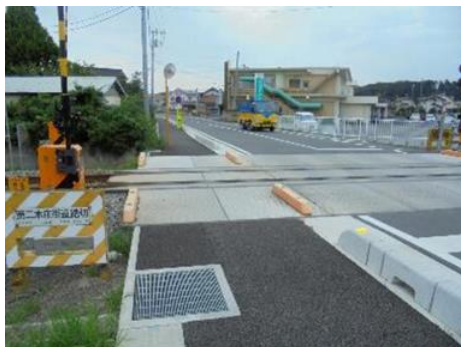
写真 2-7-31 ブロック等により分離している例
