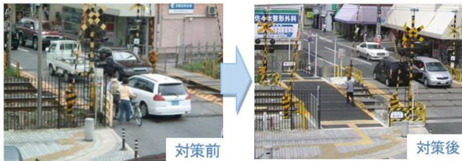
写真 2-7-23 踏切拡幅（歩道新設）の事例
