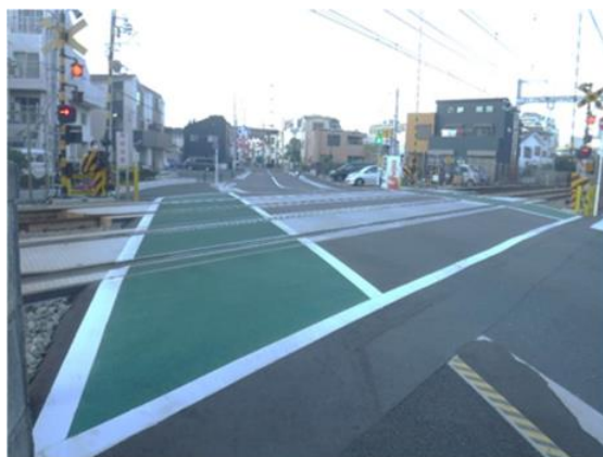
写真 2-7-24 カラー舗装を導入した事例
