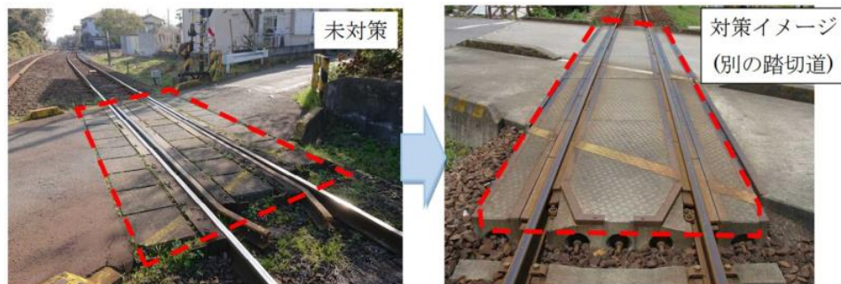
写真 2-7-35 踏切道内の平滑化イメージ
