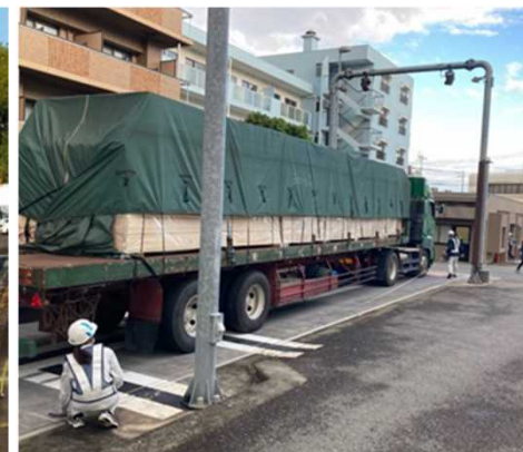
計測状況 (国道43号 兵庫県西宮市)
