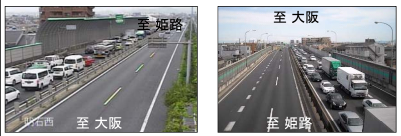
①国道2号BP明石西IC(下り線) 平成25年10月26日(土)規制時 ②国道2号BP加古川東ランプ(下り線) 平成22年4月11日(日)規制時
