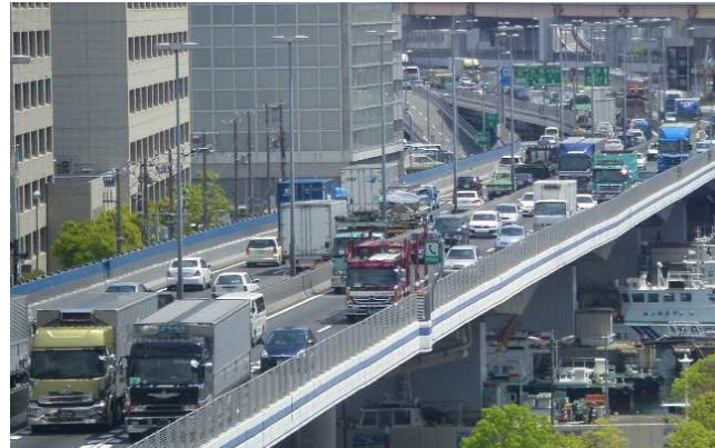
混雑する阪神高速3号神戸線(京橋ランプ付近)
