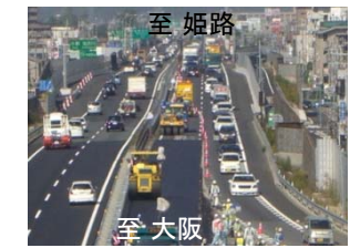
④国道250号 竜山交差点(高砂市) 平成22年7月10日(日)規制時
