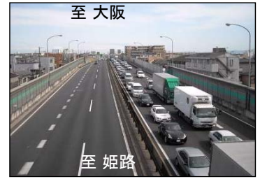
②国道2号BP加古川東ランプ(下り線) 平成22年4月11日(日)規制時
