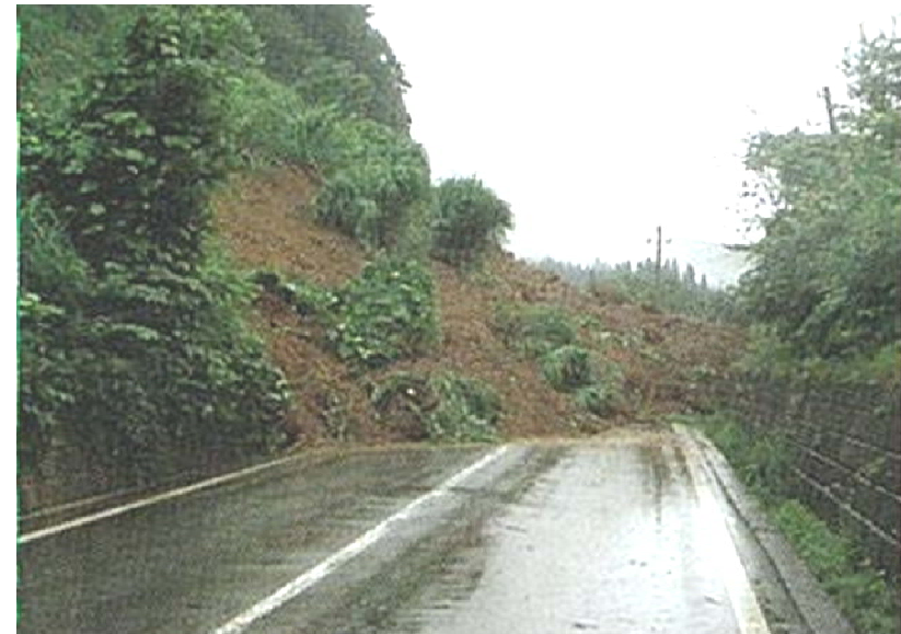
▲土砂崩落による通行止め状況
