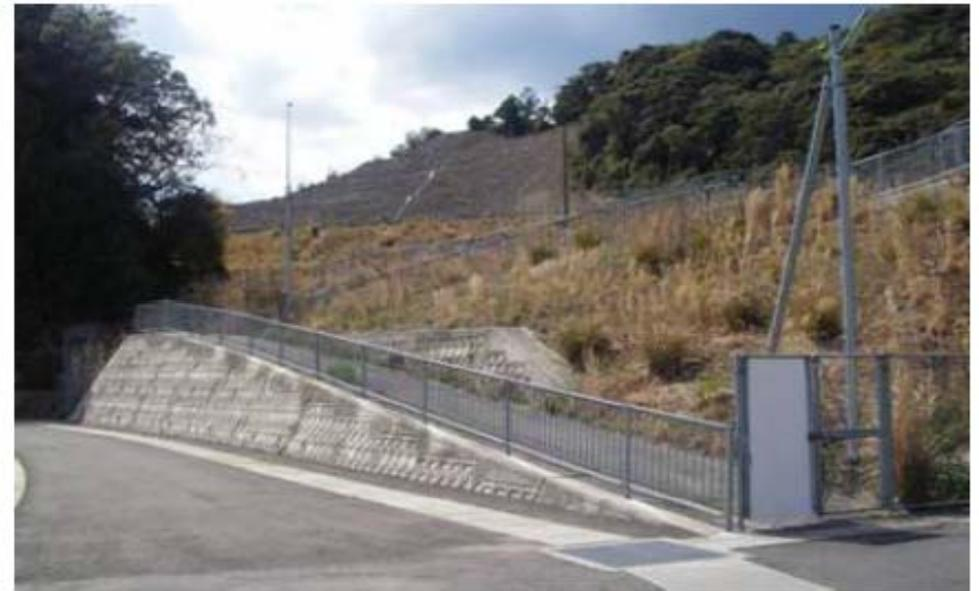
※ 緊急時には簡単に壊せる扉を設置
