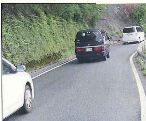
▲国道168号(宇宮原工区)
