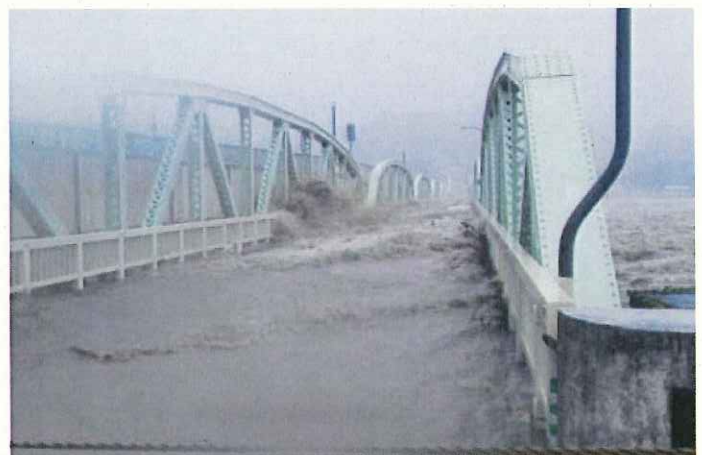
▲並行する国道42号 【平成23年9月4日 台風12号による越水状況(熊野大橋)】
