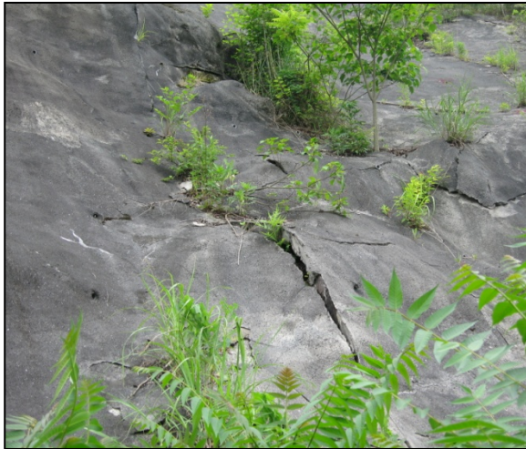
はらみ出しによるモルタルの亀裂
