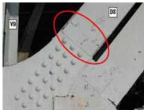
新旧トラス斜材突合せ溶接部のRT試験結果
