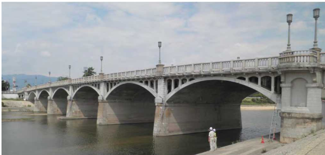
武庫大橋の全景(H18土木学会選奨土木遺産)
