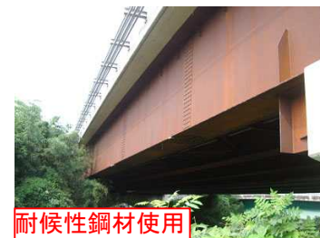
国道175号 天神橋(単純鋼非合成版桁橋)
