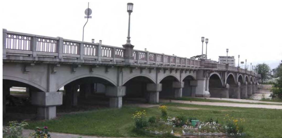
単純RCT桁(6連)+6径間連続RCアーチ橋+単純RCT桁(3連)
