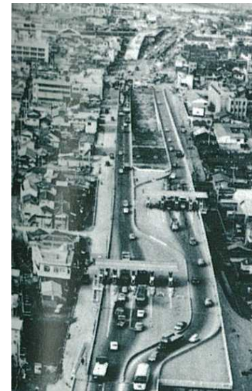
第二阪神国道安治川大橋供用 (昭和41年)
