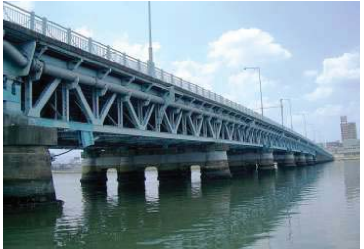
写真1 対象橋梁外観
