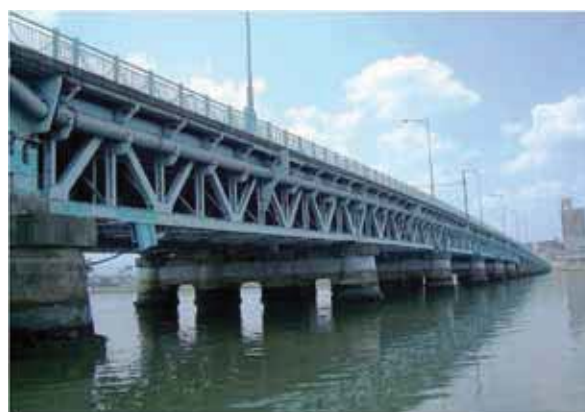
写真1 調査対象橋梁全景
