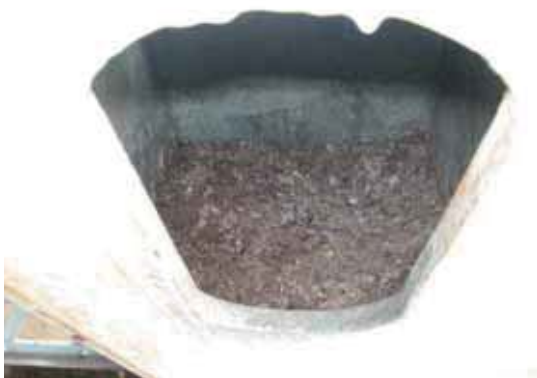
写真4 主構トラスの堆積物(鳥糞)
