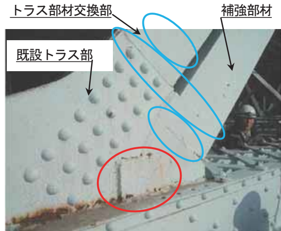
写真 4 トラス斜材補強部の非破壊試験箇所例
