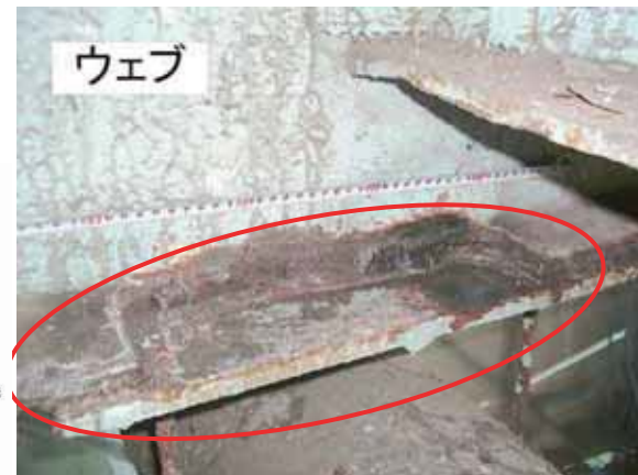
写真 5 横桁補修部の非破壊試験箇所
