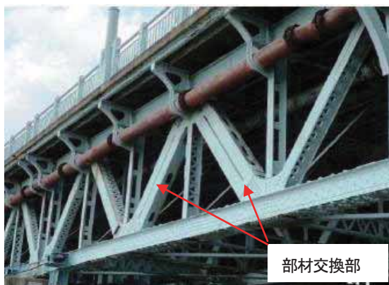
写真3 トラス斜材の補修・補強状況
