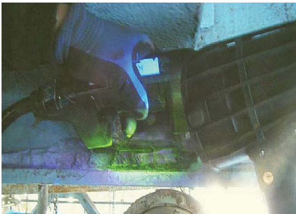
図9 横桁表面き裂の磁粉探傷試験状況
