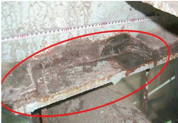
図8 横桁補修箇所の磁粉探傷試験実施箇所
