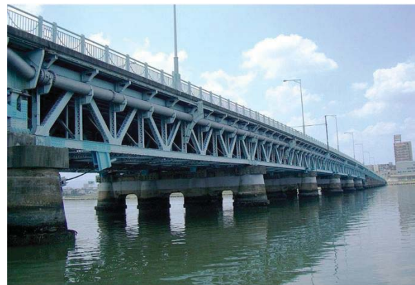
写真1 対象橋梁外観
