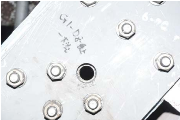
写真5 母材ビード部確認用搾孔
