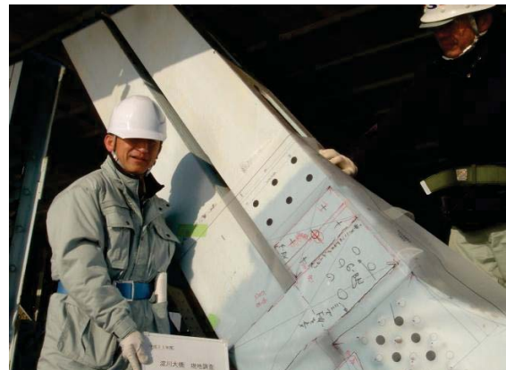
写真4 原寸図による細部確認
