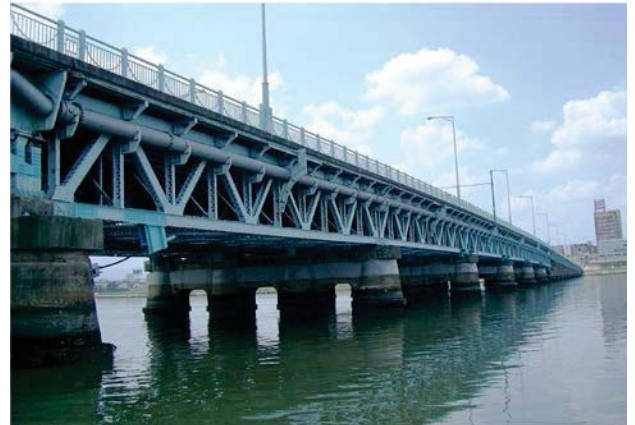
写真1 対象橋梁全景
