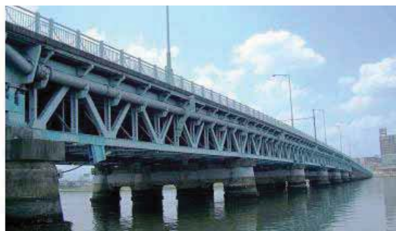
写真 1 対象橋梁の外見
