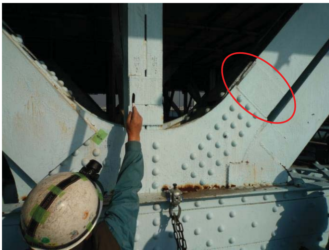
写真1. 実橋斜材突合せ状況
