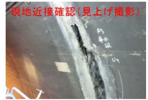
画像及び展開図より 表面が欠落し異常が考えられる
