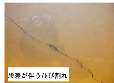
図-3 縦断方向のひび割れ箇所
