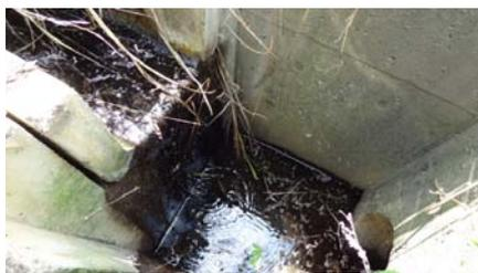
雨水が運搬する土砂でマスが次第に埋まってゆく。このような流出土の量や降雨時にマスに流れ込む排水の濁度が盛土の劣化過程についての有用な情報を与えるものとなっている。
