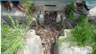
1段目の小段にあるU字溝合流ポイントのマスには大量の落ち葉が堆積している。
