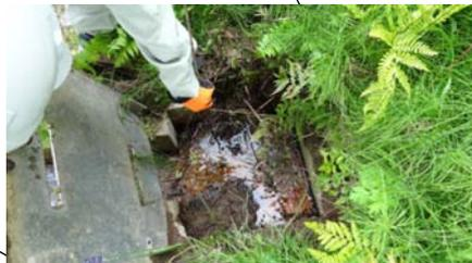
最低部のU字溝合流ポイントのマスには大量の土砂が堆積している状態。土砂堆積深さは50cm程度。
