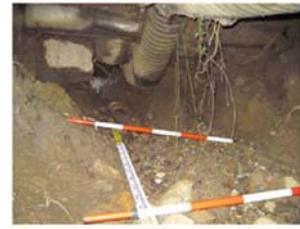
写真 5.3.4 法枠下空洞
