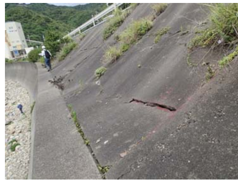
盛土側部-法面被覆工に開口亀裂が発生
