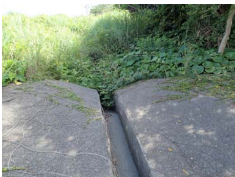
縦排水工に変状無し
