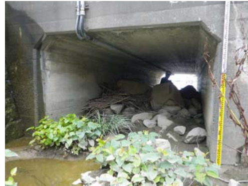
横断排水工が土砂で閉塞しかけている
