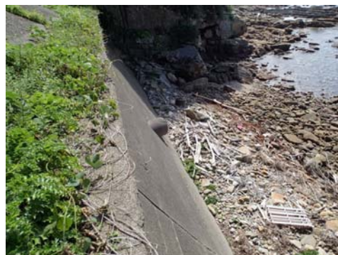
盛土基礎護岸工に変状無し
