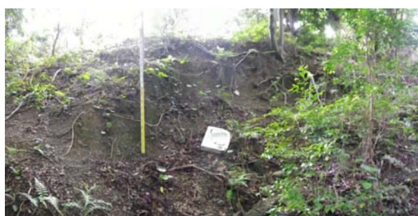
盛土側部に崩壊が発生
