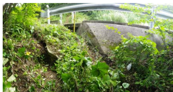
法面被覆工裏側の盛土材の吸い出し
