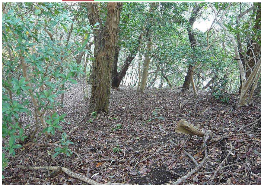
P-3 調査対象箇所の斜面状況 急傾斜を呈するが斜面下部はやや緩傾斜
