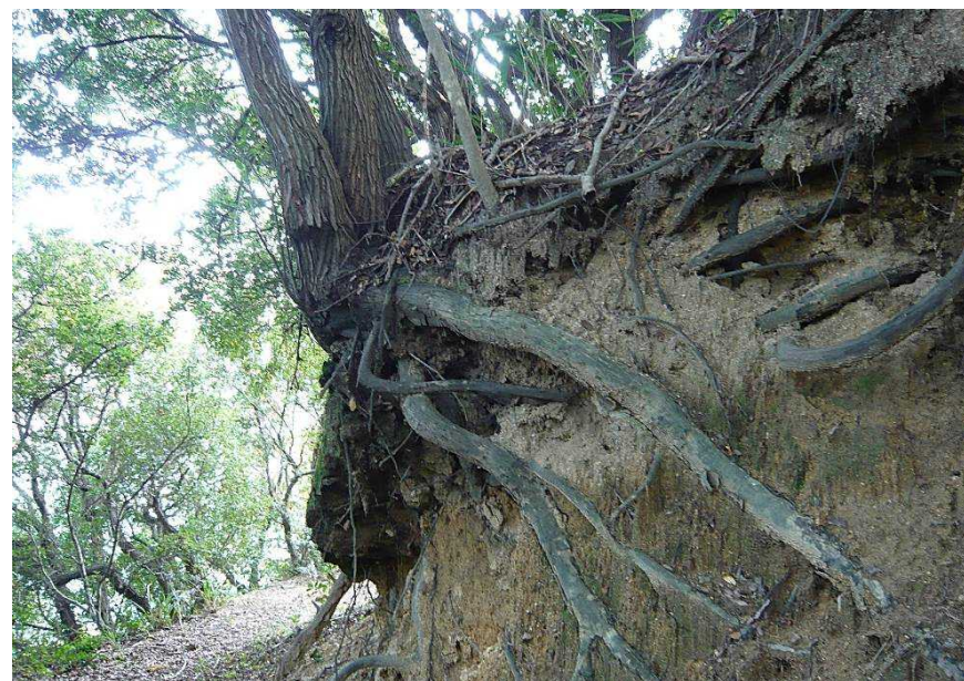
P-4 調査対象箇所直上の尾根部 表層部は風化進行し土砂状
