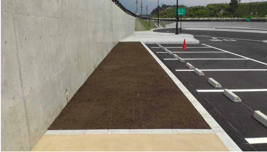
木質加熱アスファルト舗装（透水型）
