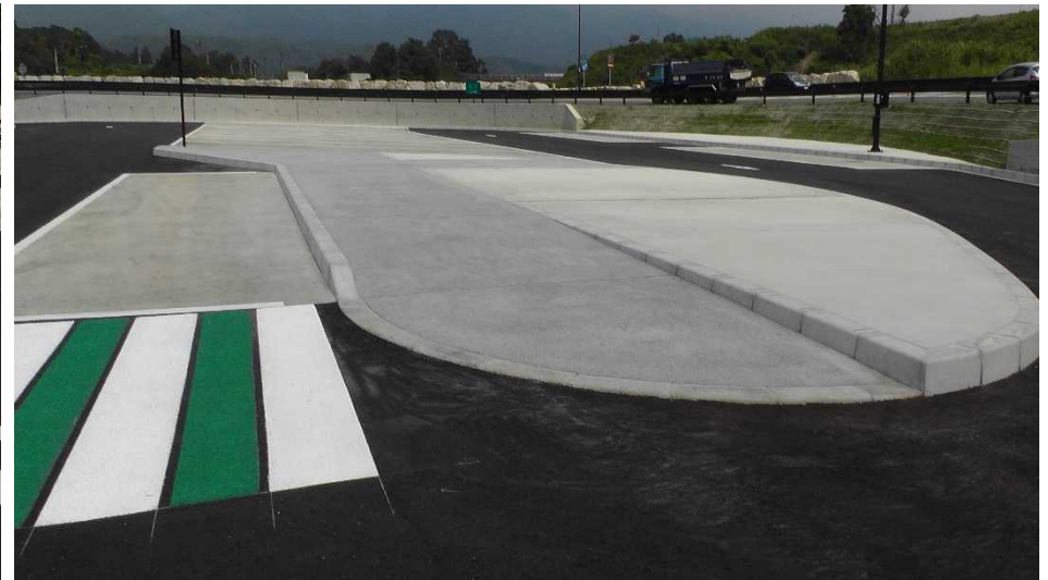
透水性コンクリート舗装「エコパック」11
