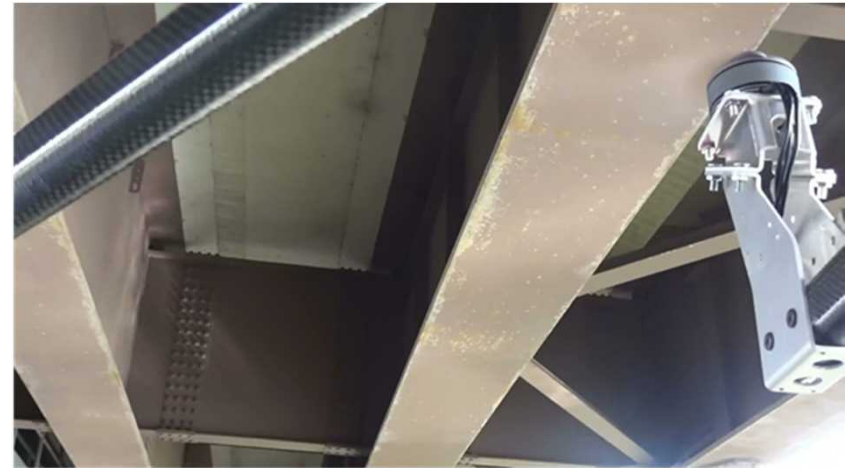
山中川側道橋
