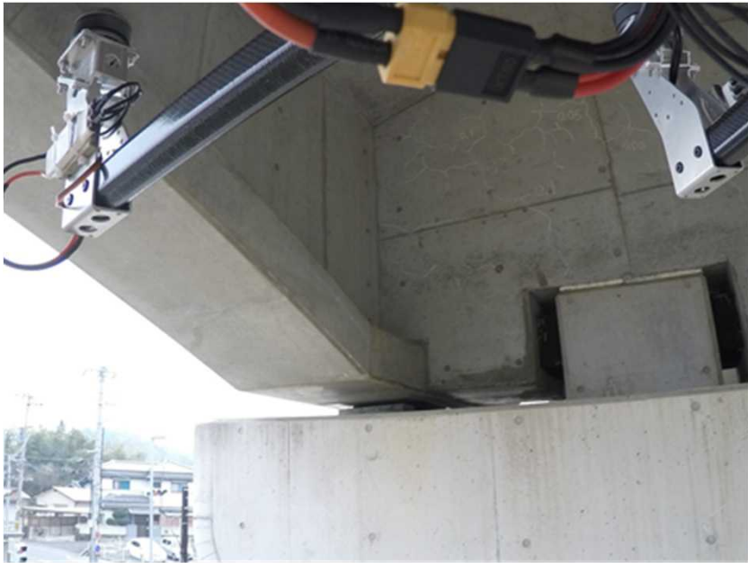
自然田高架橋
