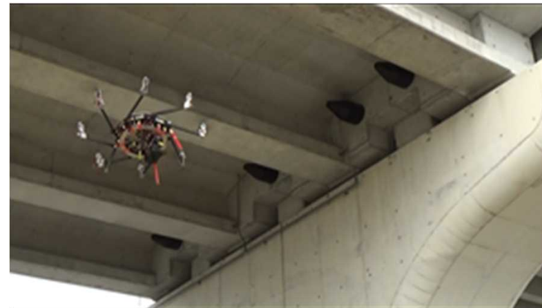
自然田高架橋撮影写真（右）
