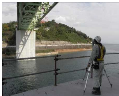
橋梁の劣化調査状況
