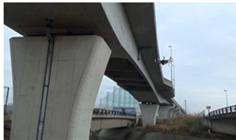
山中川高架橋写真（右）
