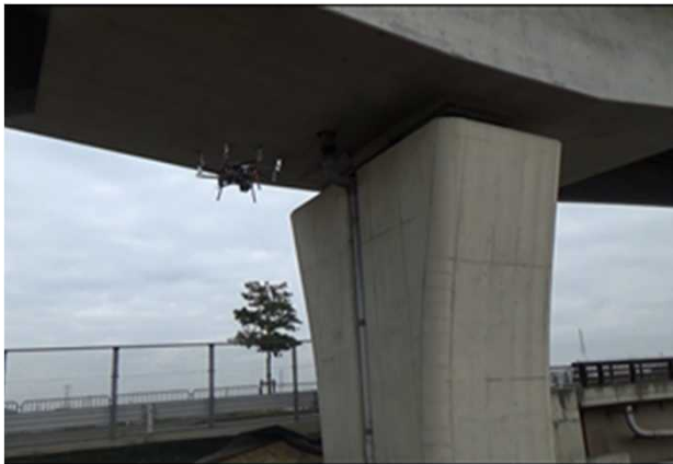
飛行ロボット橋梁計測
