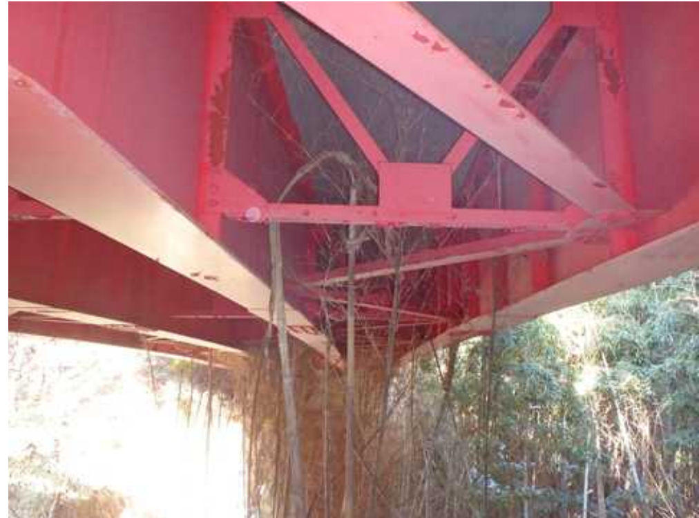
点検通路のない中小橋梁
