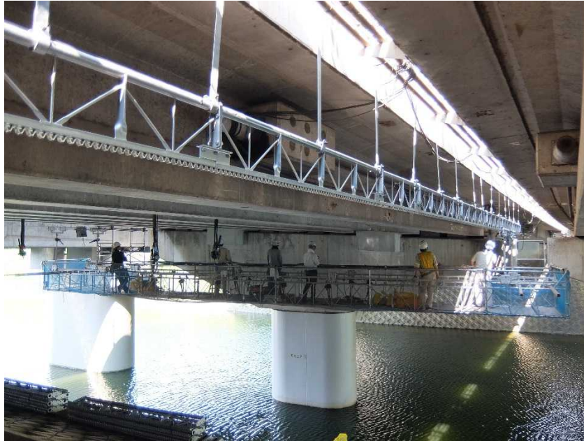
吊り足場全景
