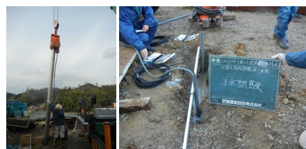
写真2 盛土防水工の施工事例
