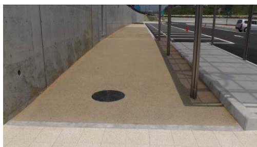
写真-4 自然石風常温透水薄層カラー舗装
