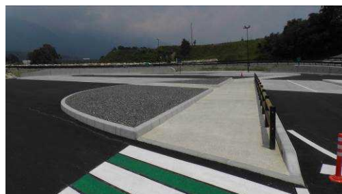
写真-3 路面温度低減舗装
