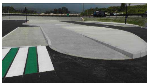
写真-9 透水性コンクリート舗装
