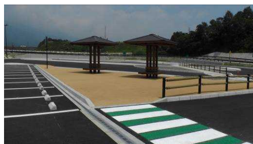
写真-8 遮熱型常温透水薄層カラー舗装
