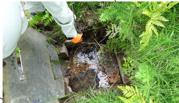
最低部のU字溝合流ポイントのマスには大量の土砂が堆積している状態. 土砂堆積深さは50cm程度.
