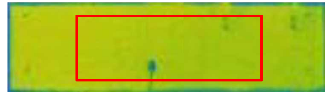
②15:04 散水冷却後 気化熱により温度低下
