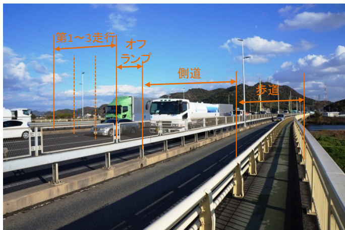
写真－1 交通状況
