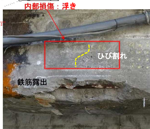
番号20 主桁Mg0102 (内部損傷:浮き)→ (表面損傷:鉄筋露出・ひび割れ)
