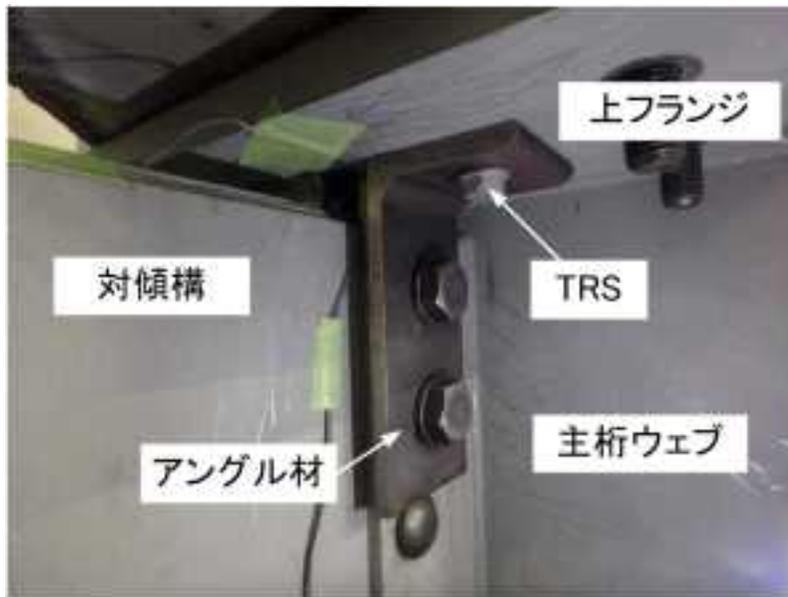
RC床版橋の垂直補剛材上端部
