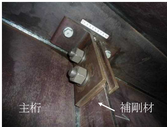
切削後当て板取り付け
