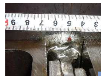
当て板取り外し前
