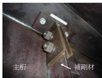
切削後当て板取り付け
