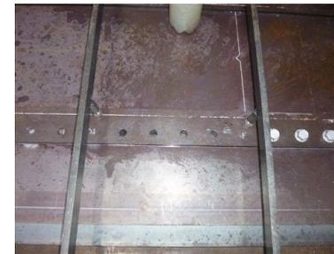
先孔(φ15.5)施工した固定板をデッキに固定治具で固定
