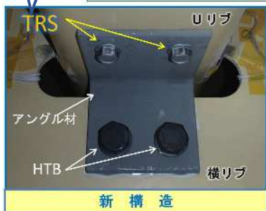
Uリブ・横リブ交差部の補強構造
