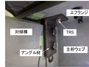
RC床版橋の垂直補剛材上端部 に対する補強工法
