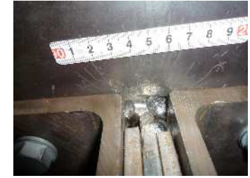
デッキ下面拡大
