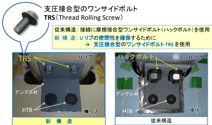
Uリブ・横リブ交差部の補強構造
