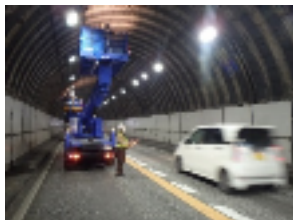
点検状況 (近接目視+打音検査)
