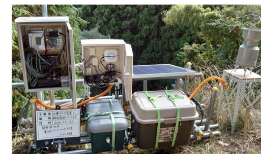
図-3 国道9号観音峠サイト
