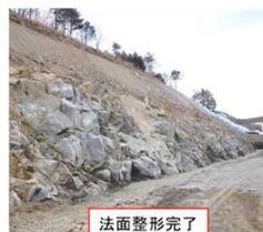
法面整形完了
