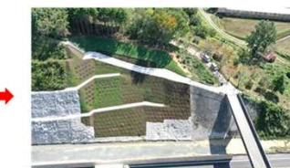
法勾配1:1.5+鉄筋挿入工に変更
