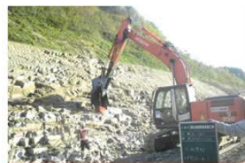
法面整形状況(大型ブレーカー使用)
