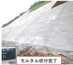
モルタル吹付完了
