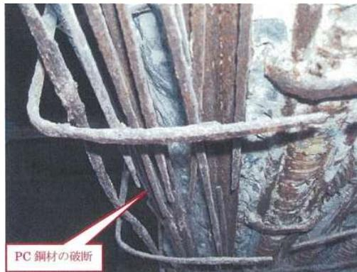
PC鋼材の腐食が進行すると，
