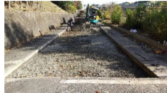
路盤改良（セメント安定処理）
