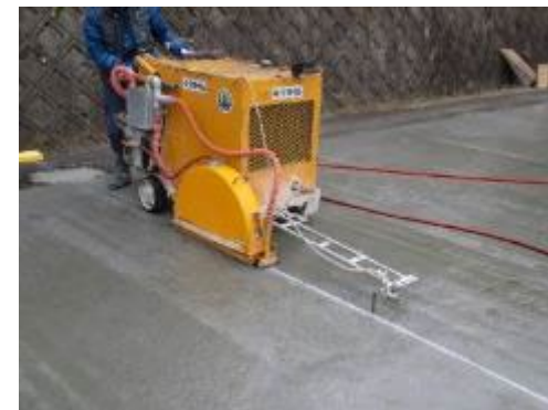
横収縮目地施工 (幅10mm, 深さ70mm)
